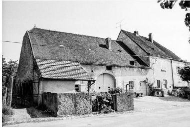
Vue d'ensemble. Phot. Bernard Pontefract IVR43_19753900417Z
