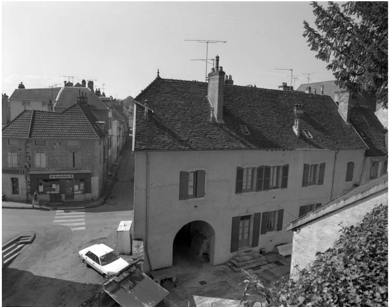
Façade postérieure en vue plongeante.
