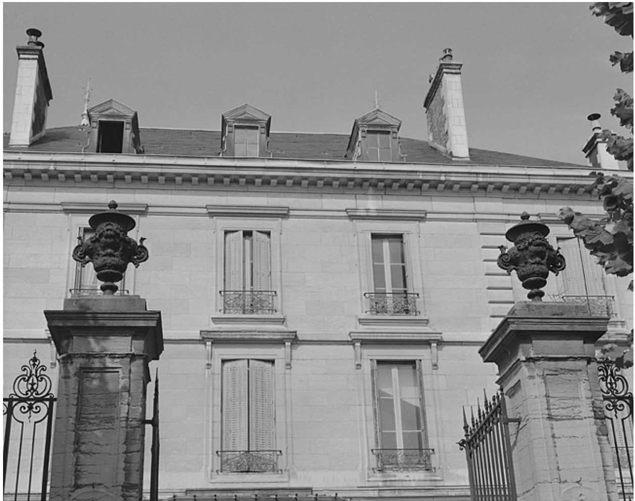
Façade antérieure, parties supérieures.
