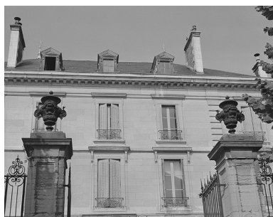
Façade antérieure, parties supérieures. Phot. Yves Sancey IVR43_19833900184X
