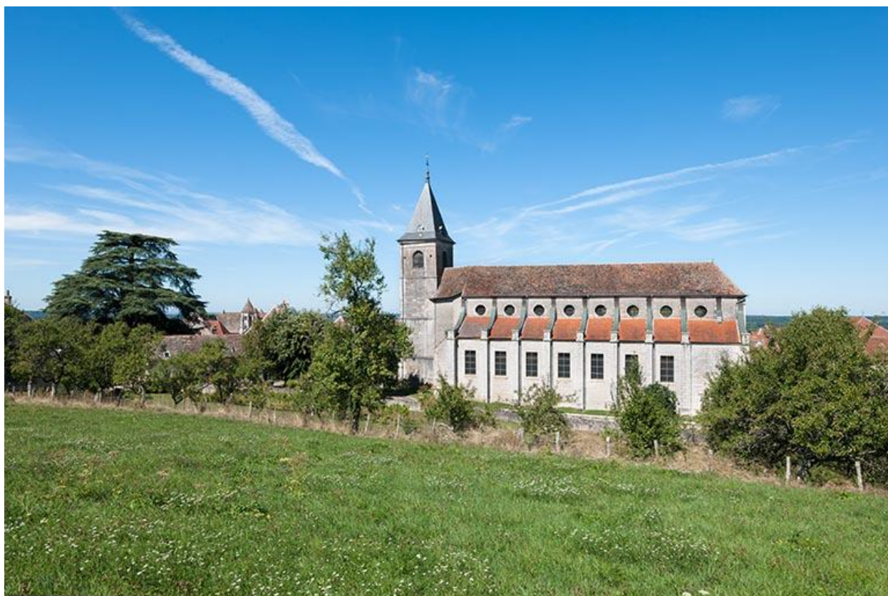
Vue générale sud de l'église
