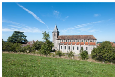
Vue générale sud de l'église Phot. Jérôme Mongreville IVR43_20137000228NUCA
