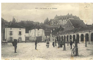
Le château et le lavoir de la place de la République IVR43_20137000770NUC2A
