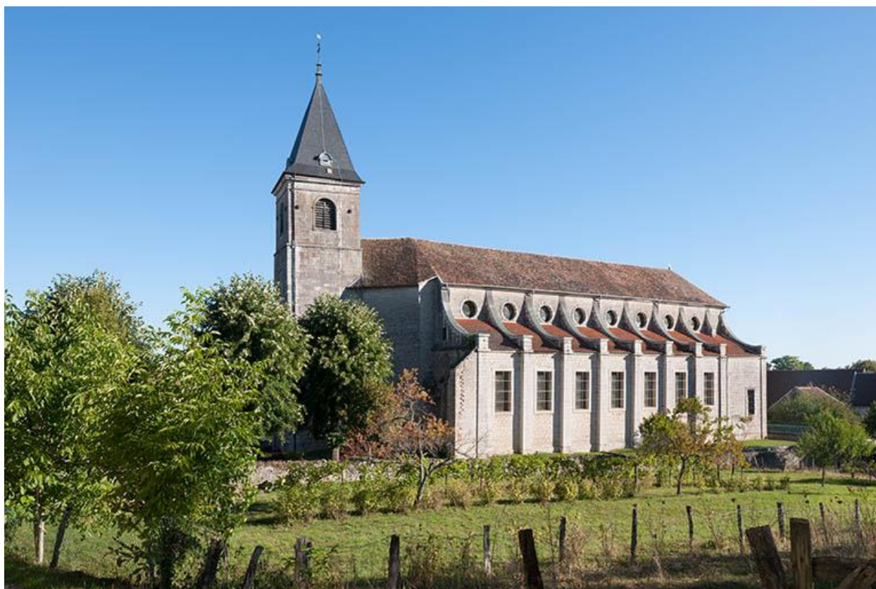
Vue sud-ouest de l'église
