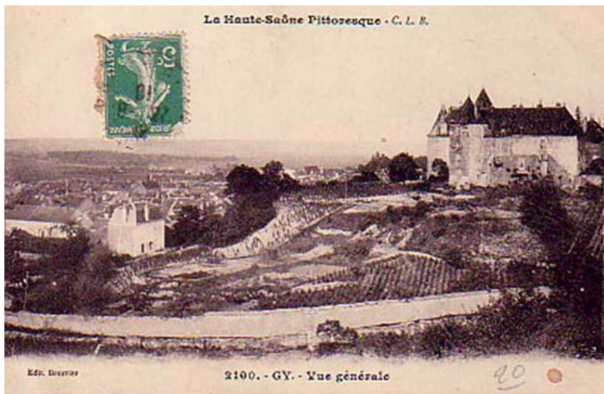
Vue générale ouest
