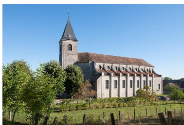
Vue sud-ouest de l'église Phot. Jérôme Mongreville IVR43_20137000234NUCA
