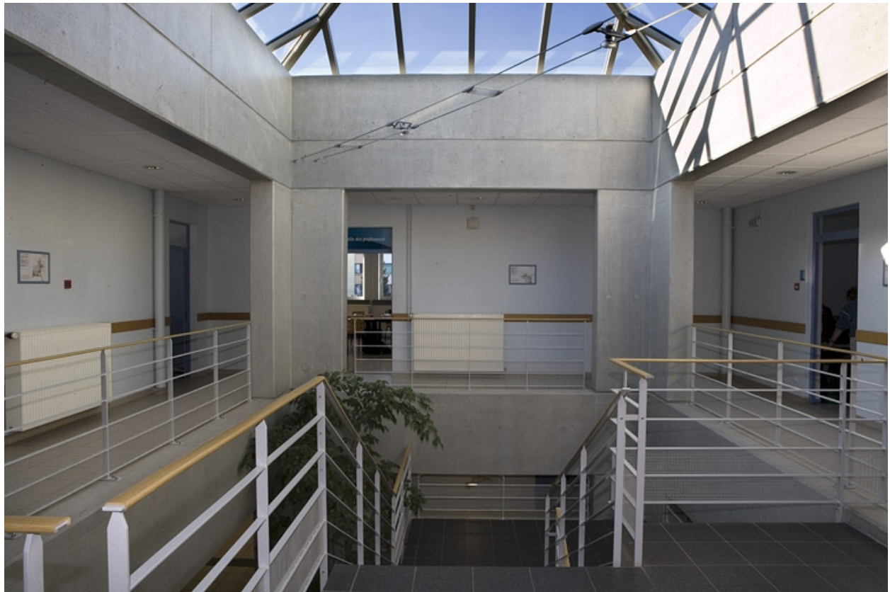
Bâtiment A. Vue de l'escalier de distribution.
