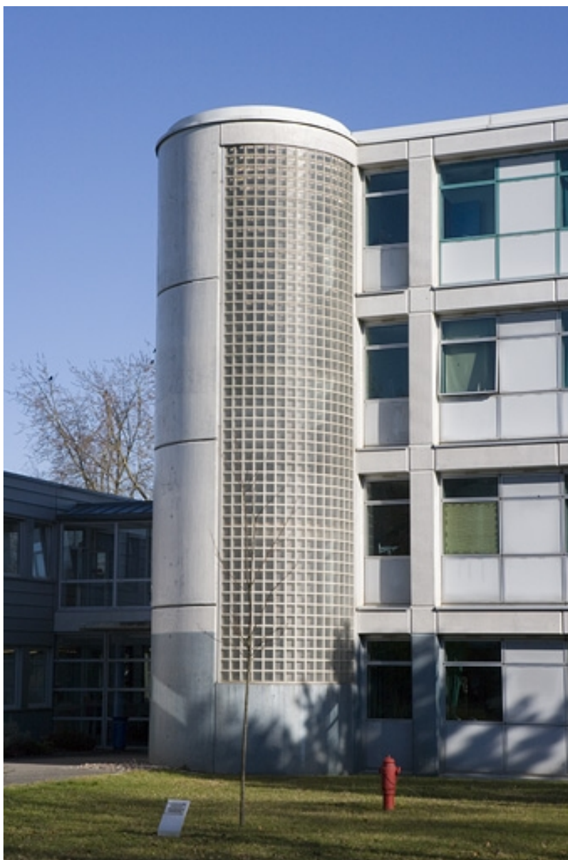
Bâtiment B. Détail de la travée d'escalier.
