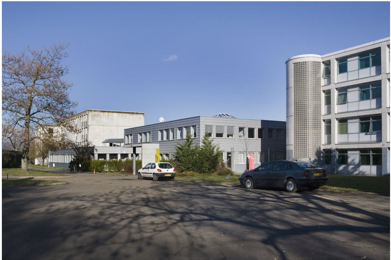
Vue d'ensemble depuis l'entrée principale.
