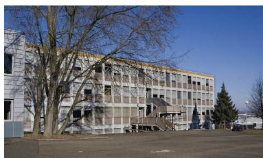
Bâtiment C. Vue de la façade antérieure. Phot. Yves Sancey IVR43_20072501051NUCA
