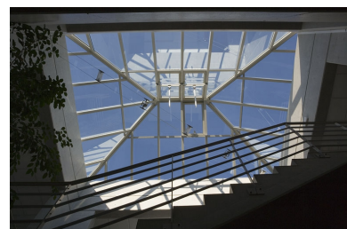
Bâtiment A. Détail de la verrière. Phot. Yves Sancey IVR43_20072501048NUCA
