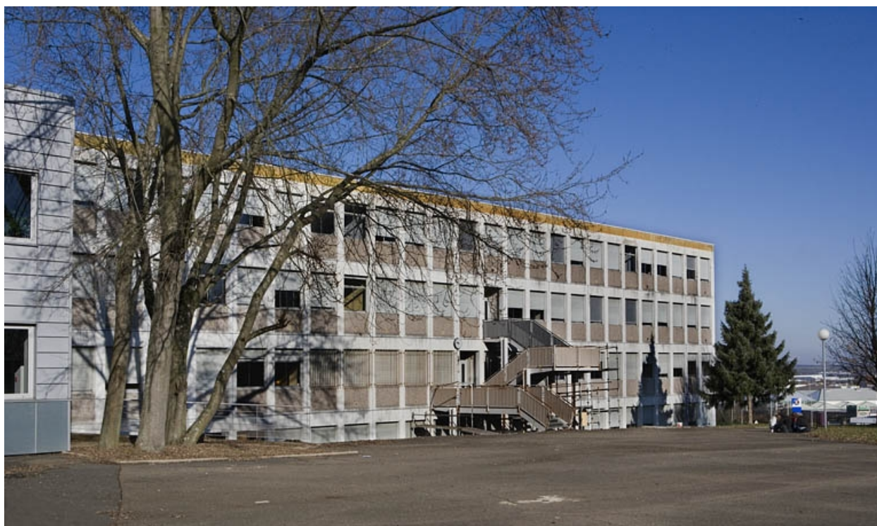
Bâtiment C. Vue de la façade antérieure.
