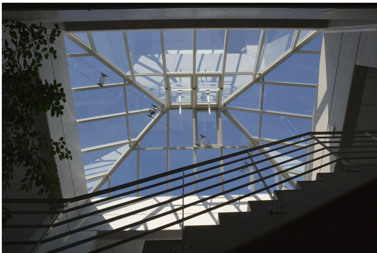
Bâtiment A. Détail de la verrière.
