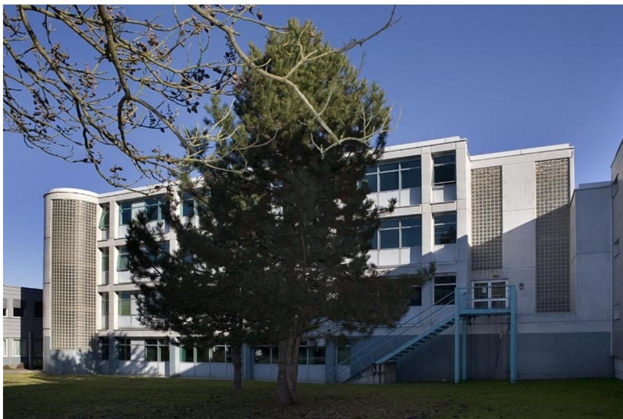
Bâtiment B. Vue de la façade antérieure.
