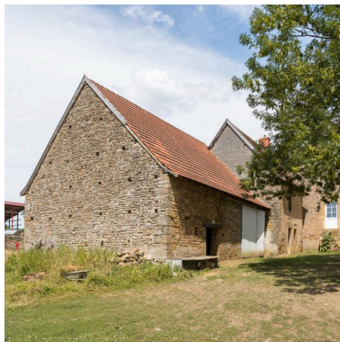
La façade antérieure et mur- pignon ouest : vue d'ensemble Phot. Pierre-Marie Barbe-Richaud IVR26_20187100163NUC2A
