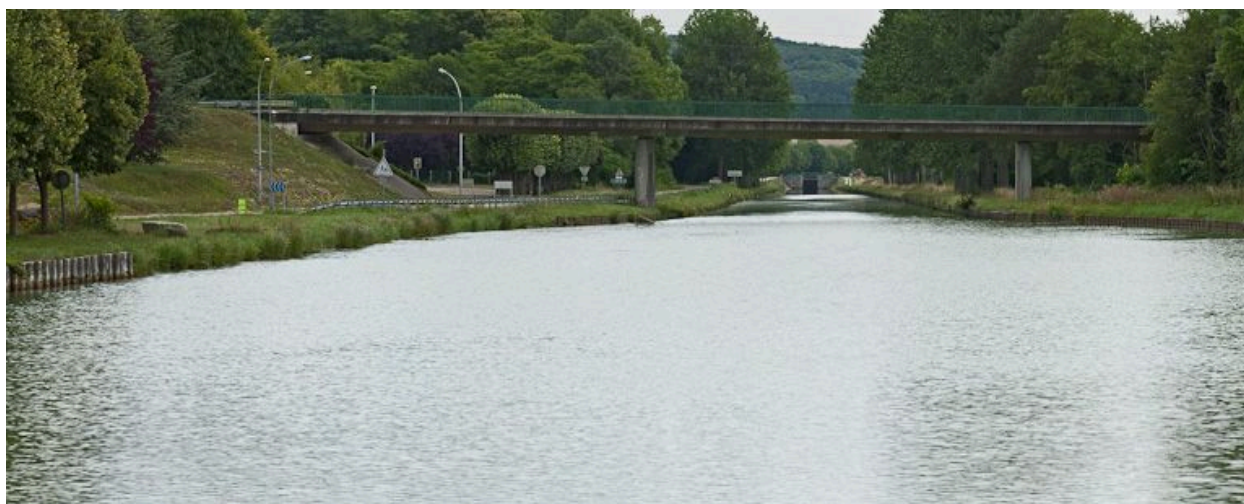
Vue du pont.
