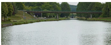
Vue du pont.
