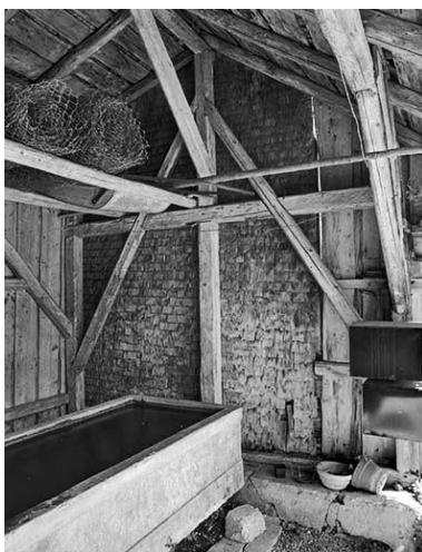
Vue de la charpente. Phot. Jérôme Mongreville IVR43_20003900226X
