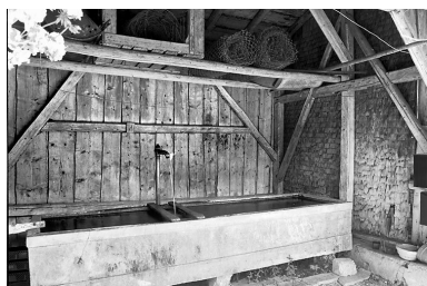
Vue du réservoir et de la charpente. Phot. Jérôme Mongreville IVR43_20003900225X
