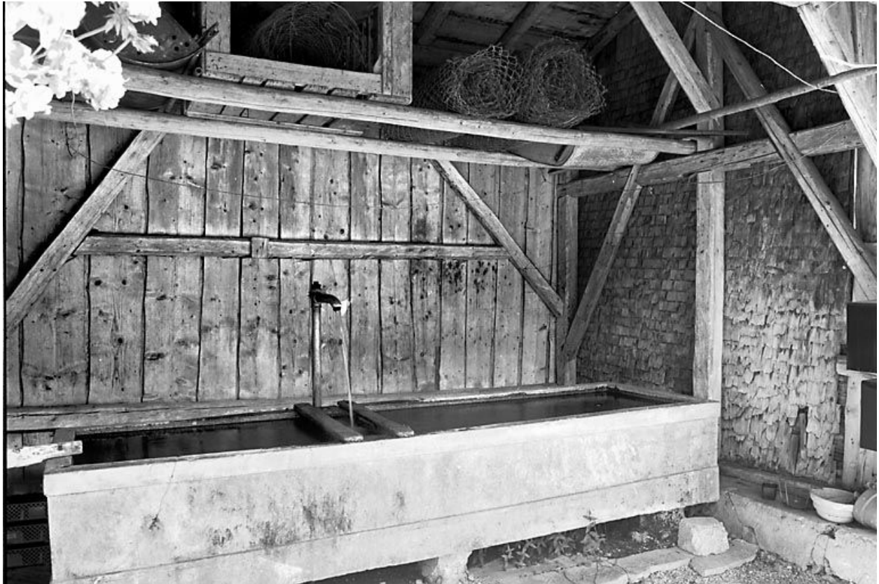
Vue du réservoir et de la charpente.
