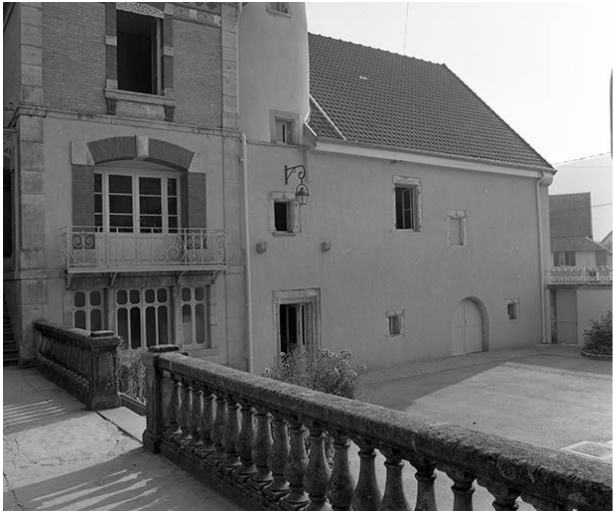
Elévation du logis.
