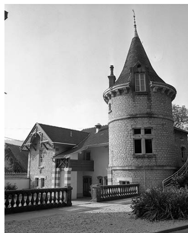
Façade antérieure des communs.
