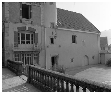
Elévation du logis.
