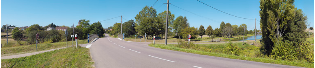
Pont sur l'écluse 03.
