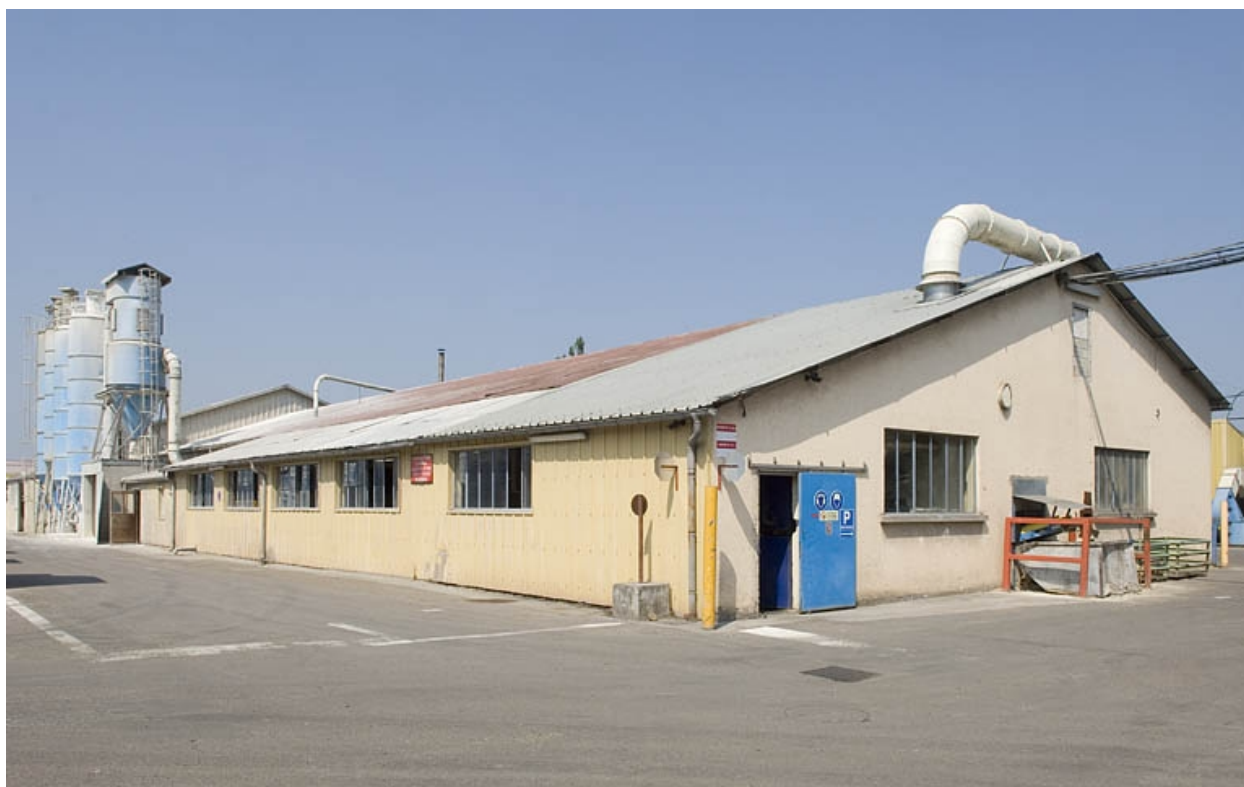
Atelier de fabrication sud.
