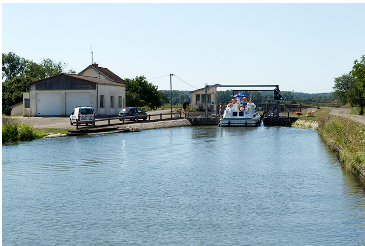
Depuis l'amont (nord), vue du site d'écluse.
