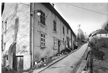
Maison de vigneron située rue du Bout d'en Haut. Phot. Jérôme Mongreville IVR43_20002500018X
