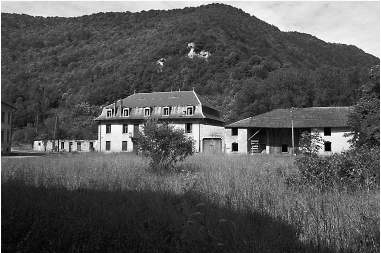
Scierie et usine de quincaillerie (clouterie) du Grand Bief ou Genestier.
