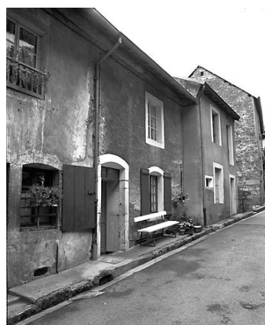
Maison de vigneron située rue de la Reine. Phot. Yves Sancey IVR43_19812500264X
