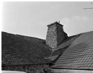
Maison située rue de Jaubourg, cadastrée 1971 AC 66 : cheminée. Phot. Yves Sancey IVR43_19802501002X
