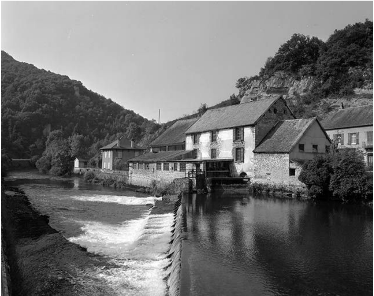
Vue générale, depuis la rive gauche de la Loue, de la minoterie Hanriot, cadastré 1971 AB 15.
