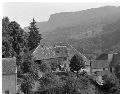
Maison située rue de l'Eglise, cadastrée 1971 AC 99 : vue depuis le sentier de la Planche. Phot. Yves Sancey IVR43_19802500986X
