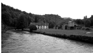
Tuilerie du Schiste, scierie. Phot. Bernard Lardière IVR43_19802500406Z
