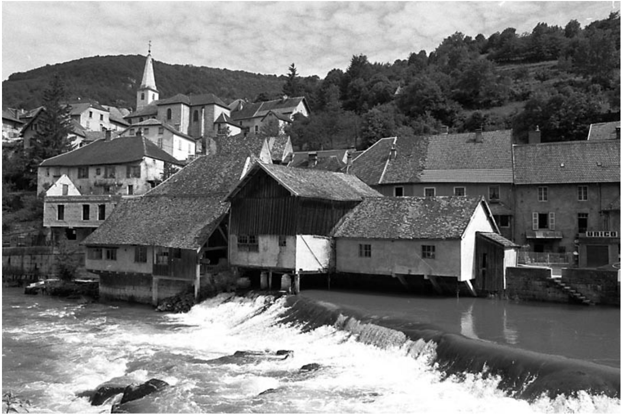
Minoterie Rondot située 7 route de Besançon.
