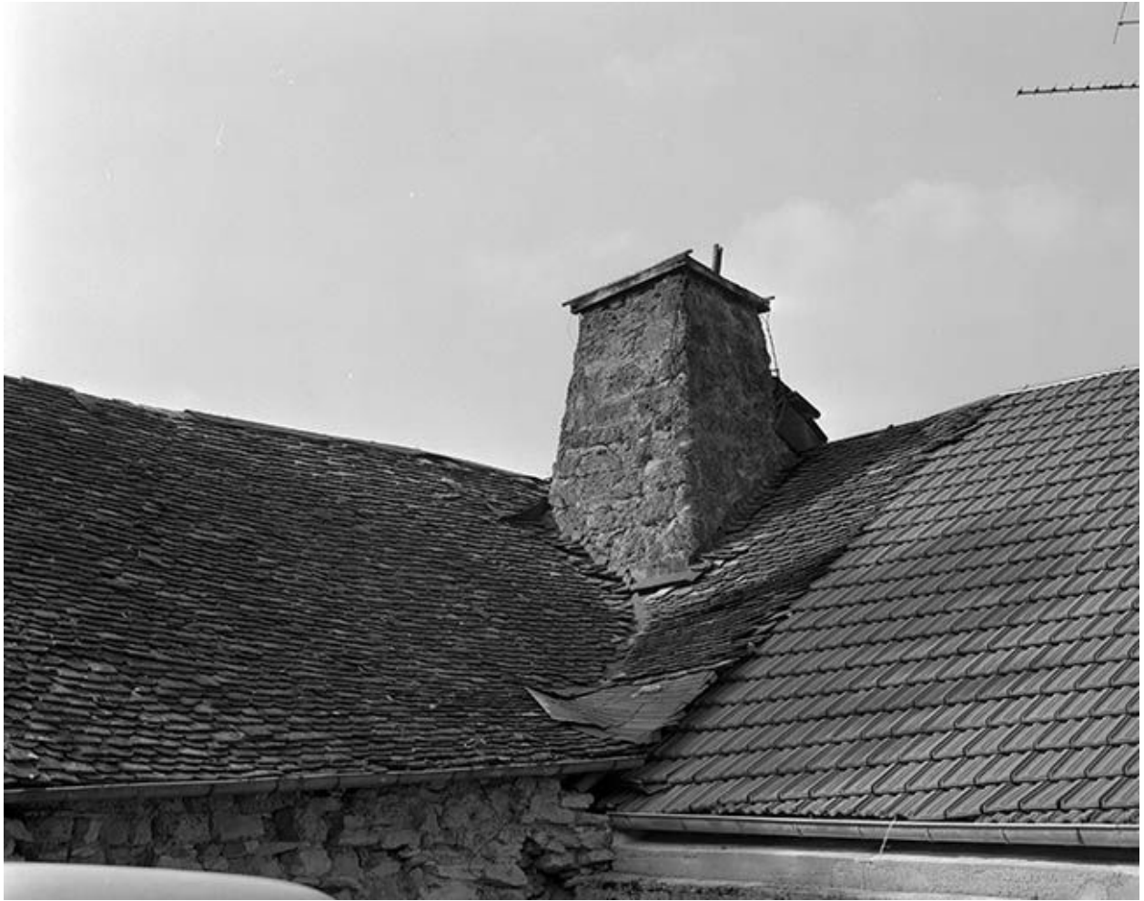
Maison située rue de Jaubourg, cadastrée 1971 AC 66 : cheminée.
