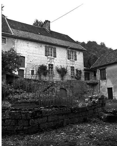
Relais de poste, actuellement maison, situé rue du Château. Phot. Yves Sancey IVR43_19812500258X
