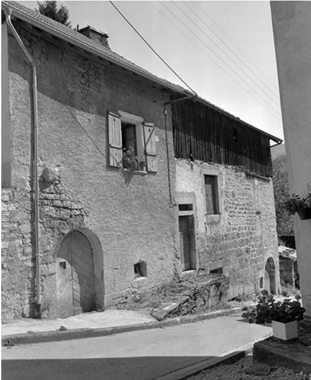
Maison située rue de Jaubourg, cadastrée 1971 AC 66.
