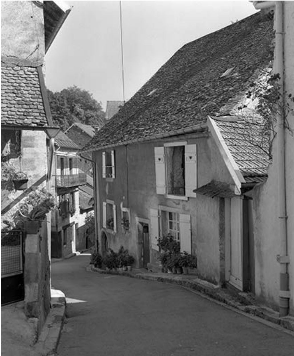
La descente de la rue de Reine.
