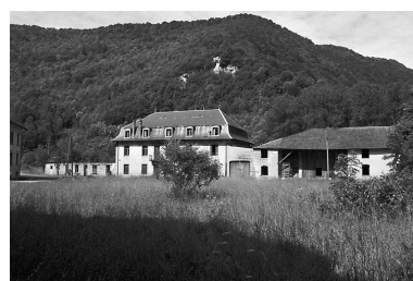
Scierie et usine de quincaillerie (clouterie) du Grand Bief ou Genestier. Phot. Bernard Lardière IVR43_19802500405Z
