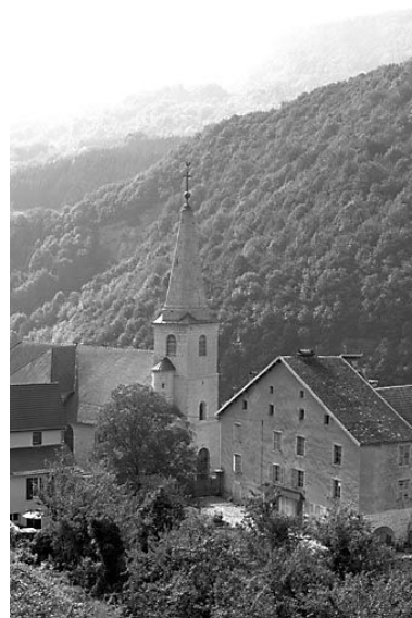
Maison située rue de l'Eglise. Phot. Yves Sancey IVR43_19802500970X
