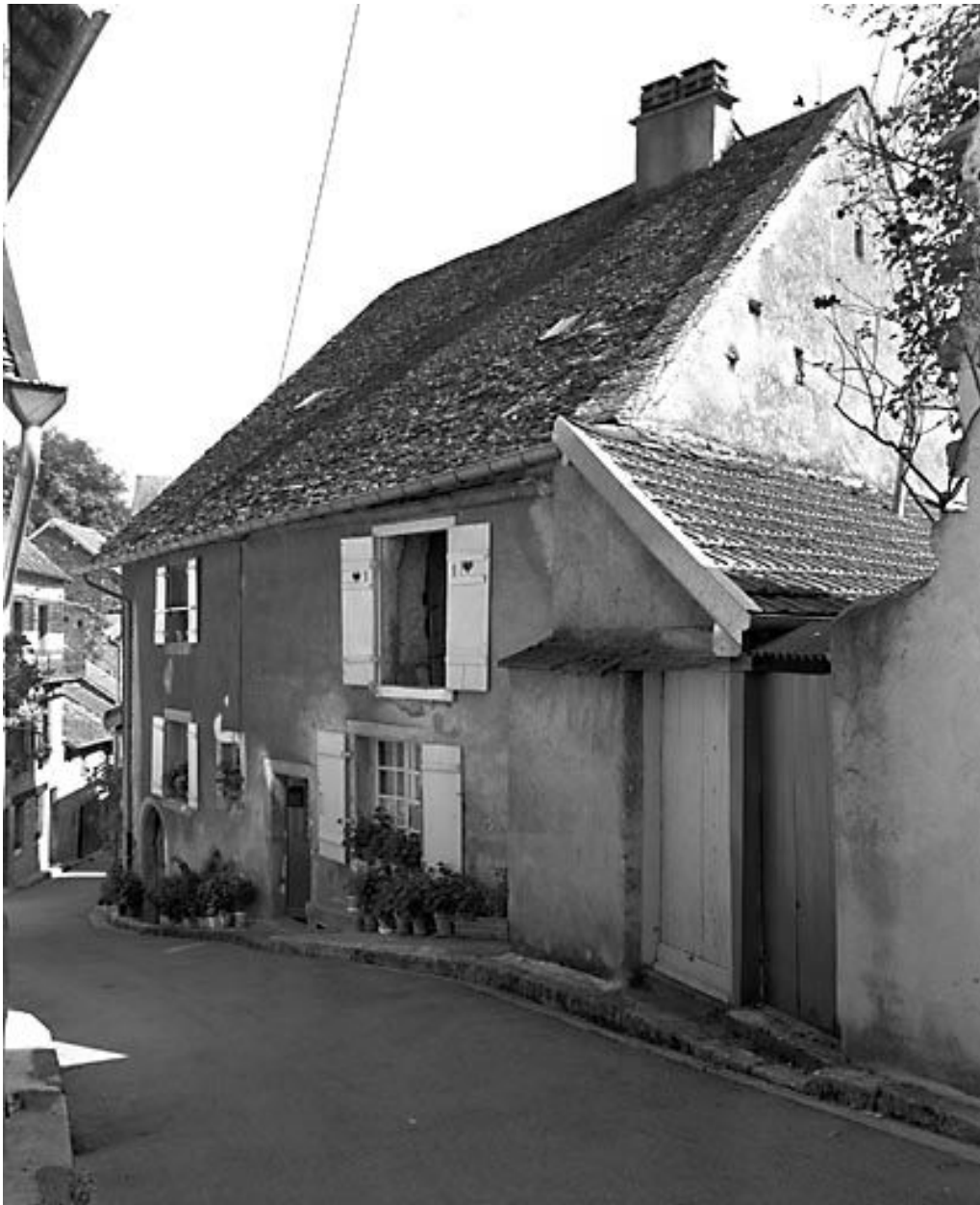
Maison de vigneron située rue de la Reine.
