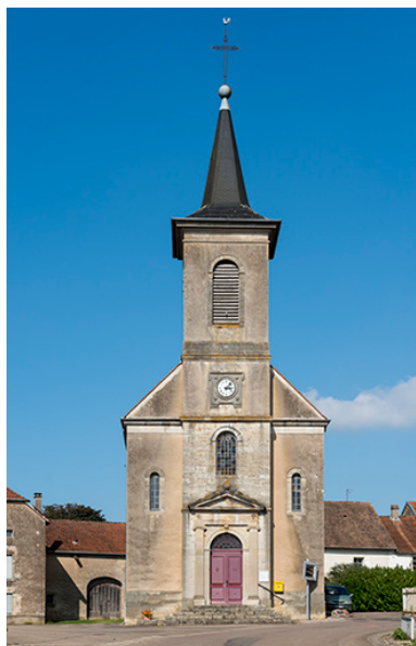
L'édifice depuis la Grande rue. Phot. Jérôme Mongreville IVR43_20167001600NUC4A
