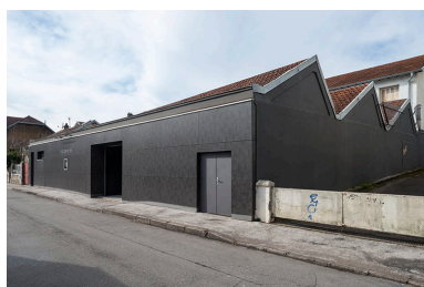
Vue de trois quarts droite. Phot. Jérôme Mongreville IVR43_20182500540NUC4A
