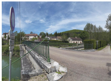
Pont vu d'aval. Phot. Thierry Kuntz IVR26_20122102440NUC4A
