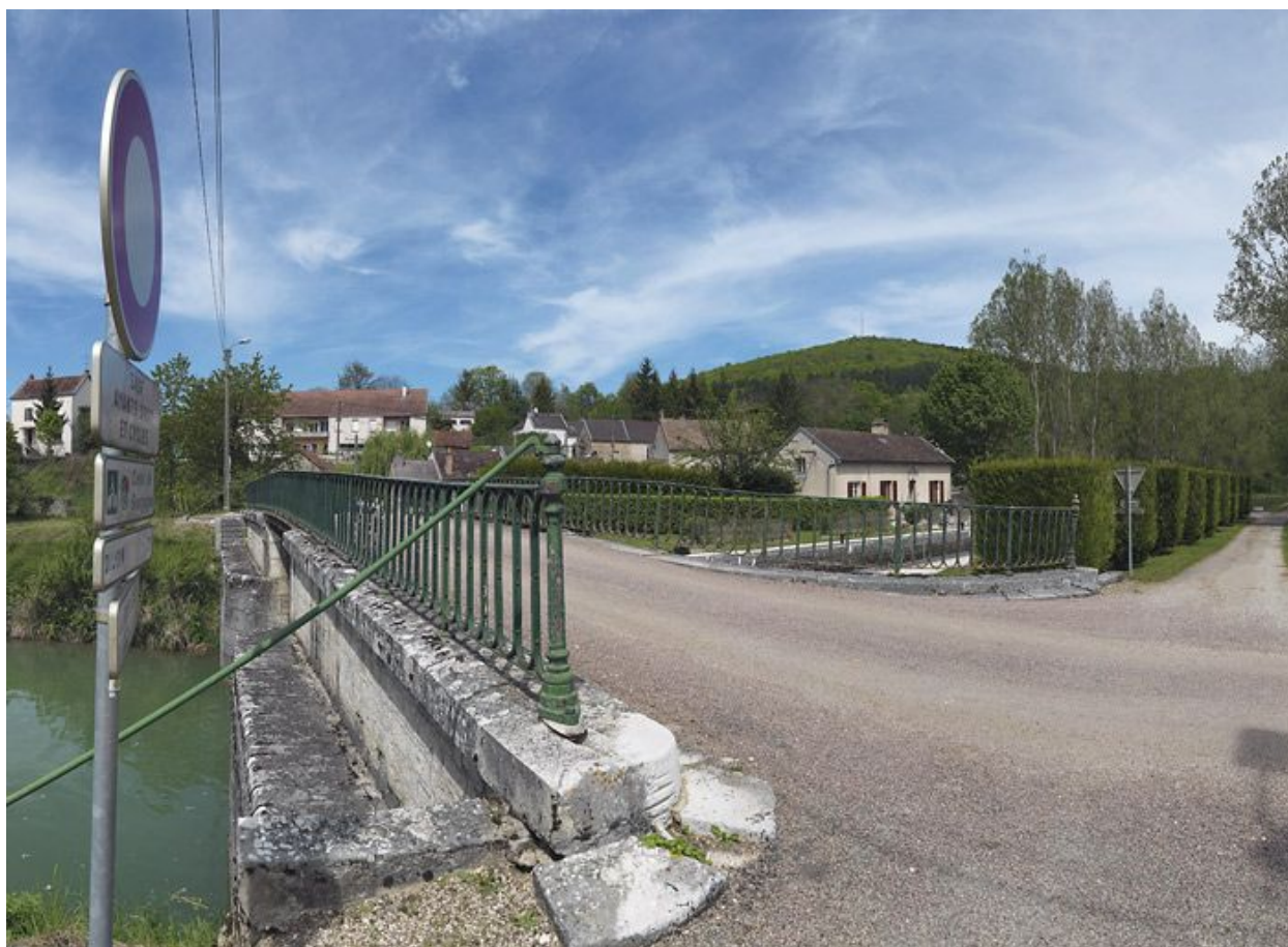
Pont vu d'aval.
