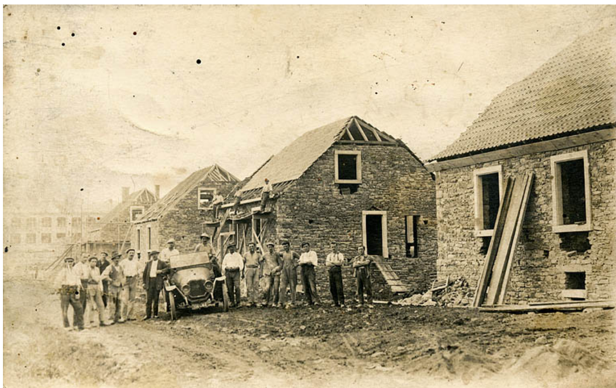
La cité ouvrière des Polognes en construction.
