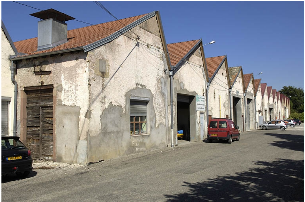
Murs-pignons sud du tissage.
