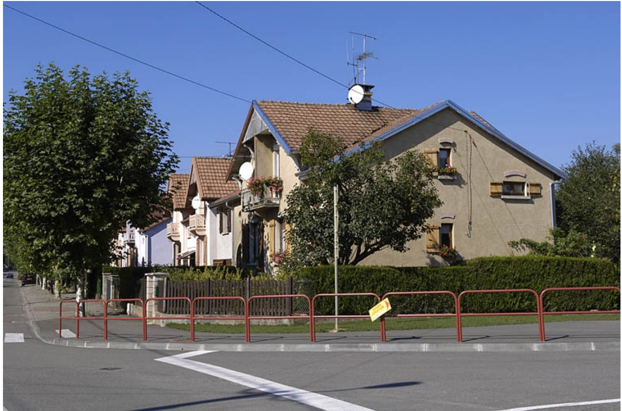
Logements ouvriers faubourg de Montbéliard.
