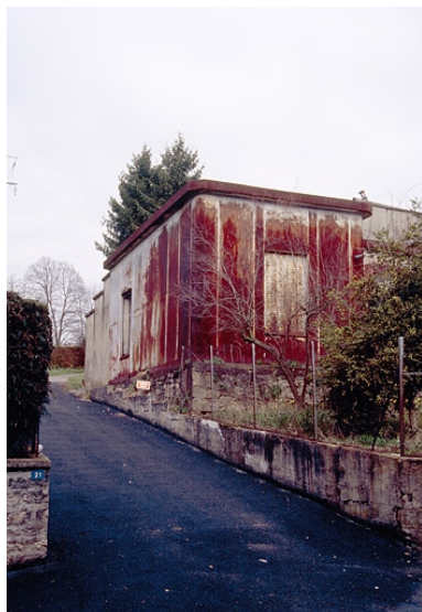
Vue d'ensemble. Phot. Yves Sancey IVR43_19943900828ZA
