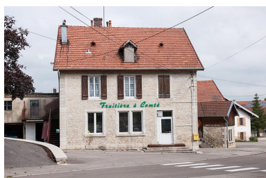
Façade antérieure. Phot. Jérôme Mongreville IVR43_20142501201NUC4A
