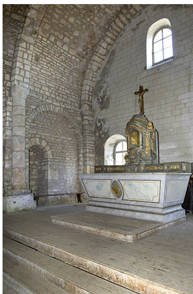
Vue générale de trois quarts gauche. Phot. Jérôme Mongreville IVR43_20052500092NUCA
