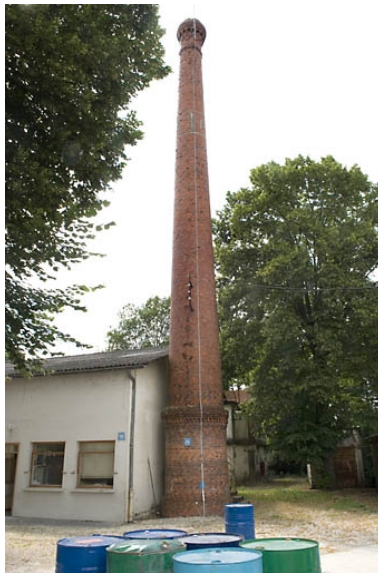
Vue d'ensemble de la cheminée. Phot. Jérôme Mongreville IVR43_20087000732NUC2A
