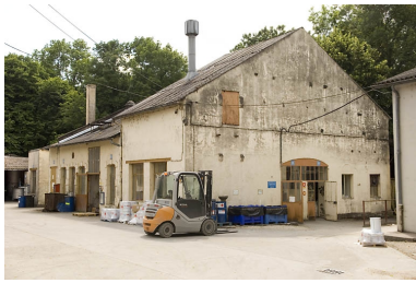
Atelier de fabrication. Phot. Jérôme Mongreville IVR43_20087000730NUC2A
