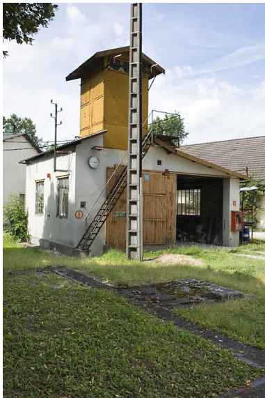
Transformateur et garage. Phot. Jérôme Mongreville IVR43_20087000729NUC2A
