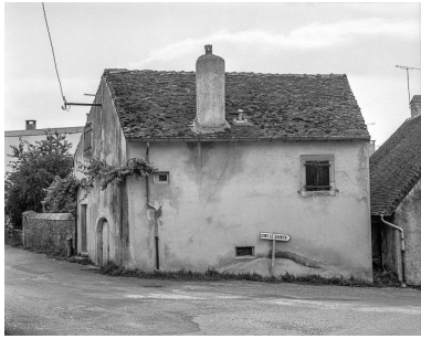
Maison de vigneron située chemin des Vannodes. Phot. Yves Sancey IVR43_19843900069X
