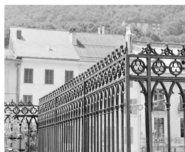
Travée fixe en retour, côté presbytère. Phot. Yves Sancey IVR43_20033900840X
