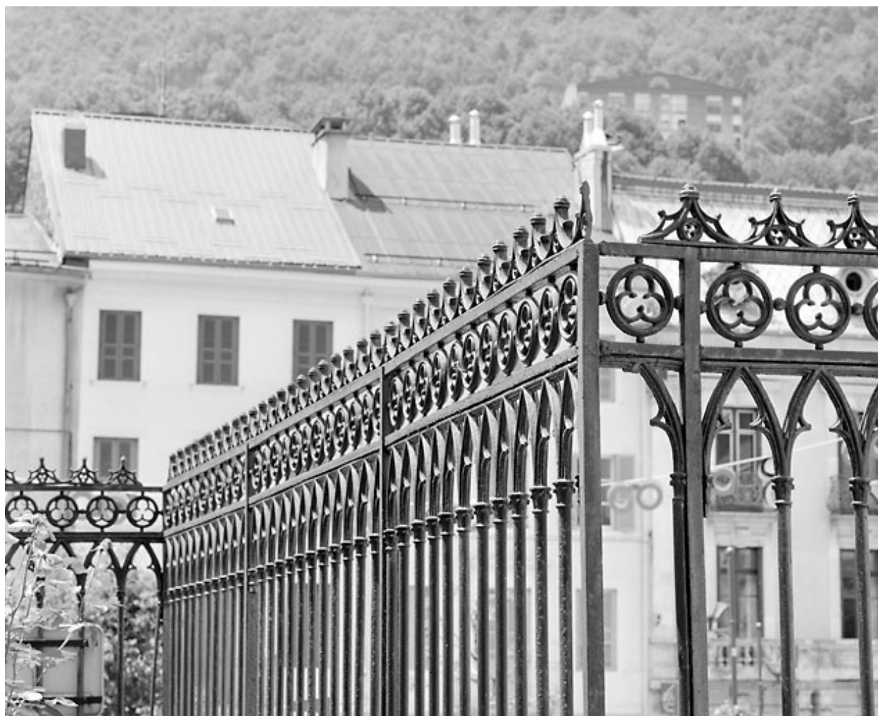
Travée fixe en retour, côté presbytère.
