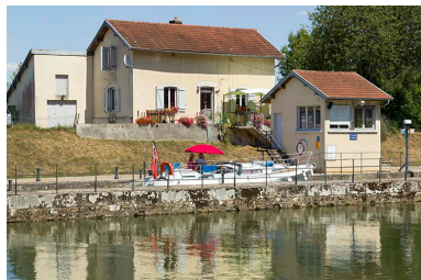
Vue de trois-quart sud- ouest de la maison d'éclusier et du poste de commande. Phot. Sonia Dourlot IVR43_20157000758NUC2A
