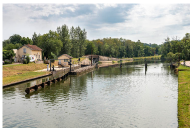
Le site d'écluse. Phot. Jérôme Mongreville IVR43_20207000209NUC4A
