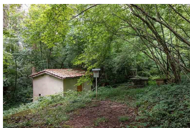
Vue d'ensemble. Phot. Fabien Dufoulon IVR26_20217100104NUC2A
