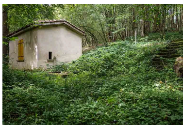
Bâtiment principal. Phot. Fabien Dufoulon IVR26_20217100106NUC2A
