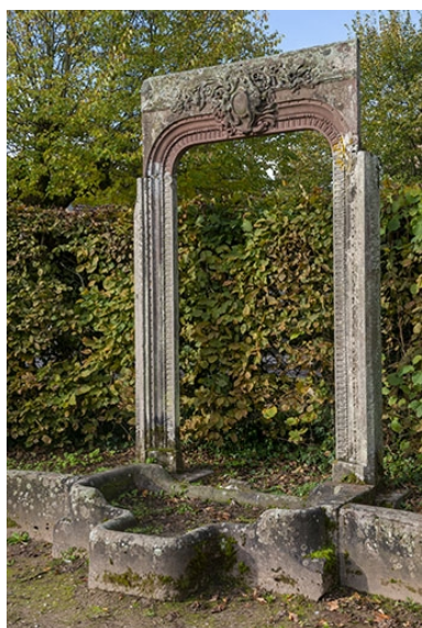
Encadrement de porte, vue de trois quarts. Phot. Jérôme Mongreville IVR43_20207000715NUC4A
