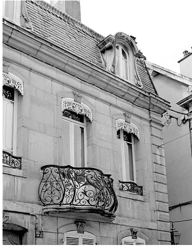
Façade antérieure, balcon. Phot. Yves Sancey IVR43_19833900202X
