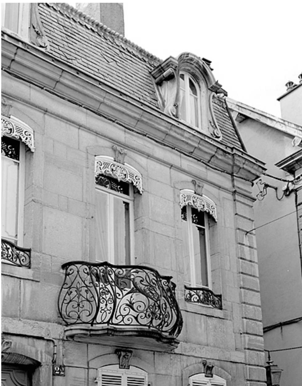
Façade antérieure, balcon.
