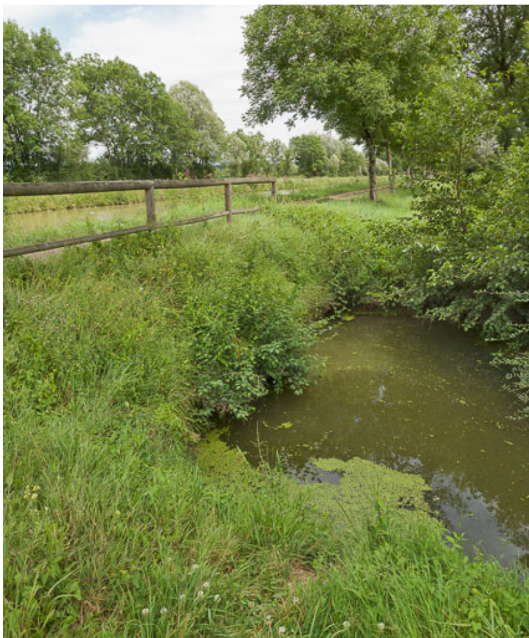
Vue de l'aqueduc.
