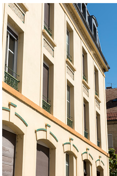
Façade latérale gauche : détail des baies. Phot. Sonia Dourlot IVR43_20182500924NUC4A
