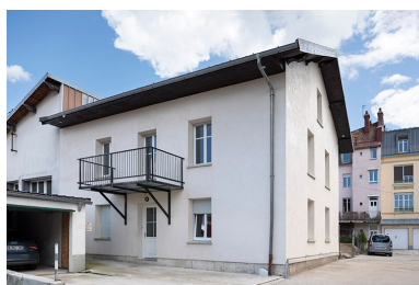
Maison (dans la cour). Phot. Sonia Dourlot IVR43_20182500923NUC4A
