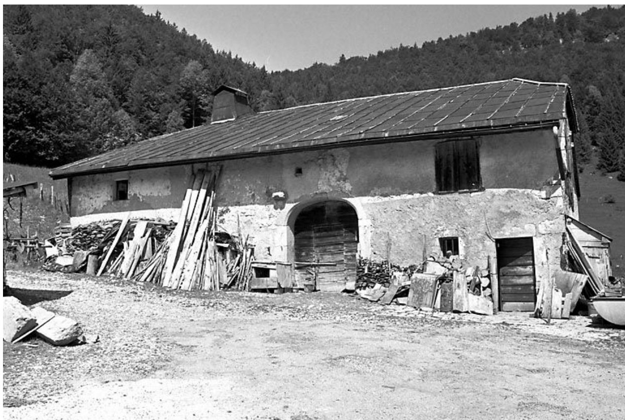
Ferme située au lieudit Près des Arcets.
