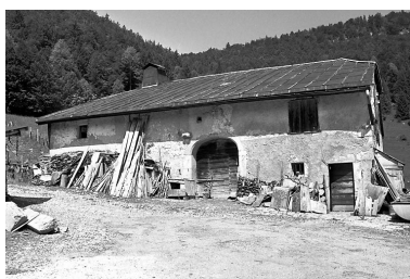
Ferme située au lieudit Près des Arcets. Phot. Jérôme Mongreville IVR43_20003900170X
