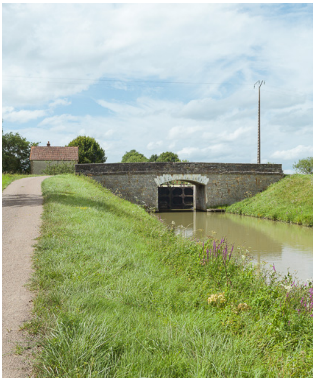
Vue d'ensemble du pont.
