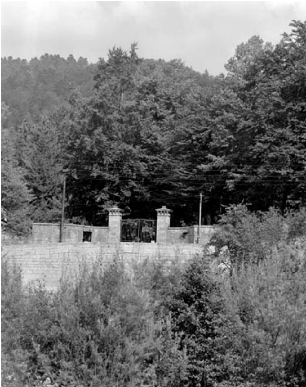
Vue éloignée du portail d'entrée, de face.
