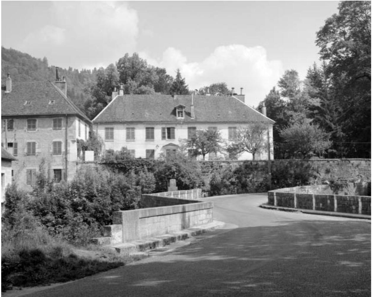
Façade antérieure depuis le pont.
