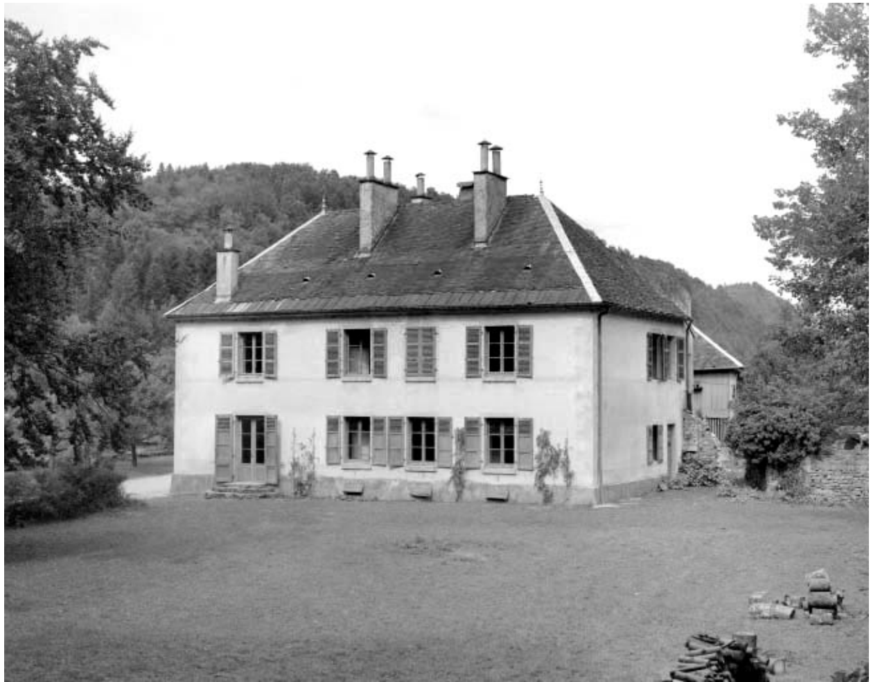
Façade latérale droite de l'habitation, vue rapprochée.
