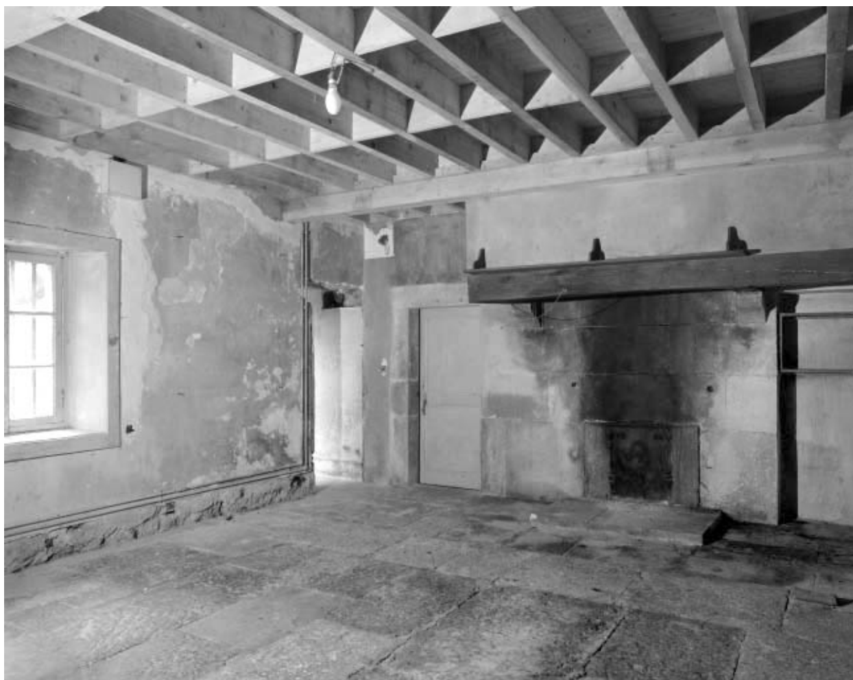
Intérieur de l'habitation : la cuisine.
