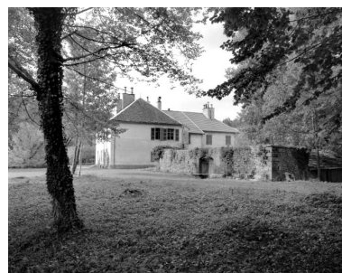
Façade postérieure de l'habitation depuis le parc. Phot. Yves Sancey IVR43_19923901015X
