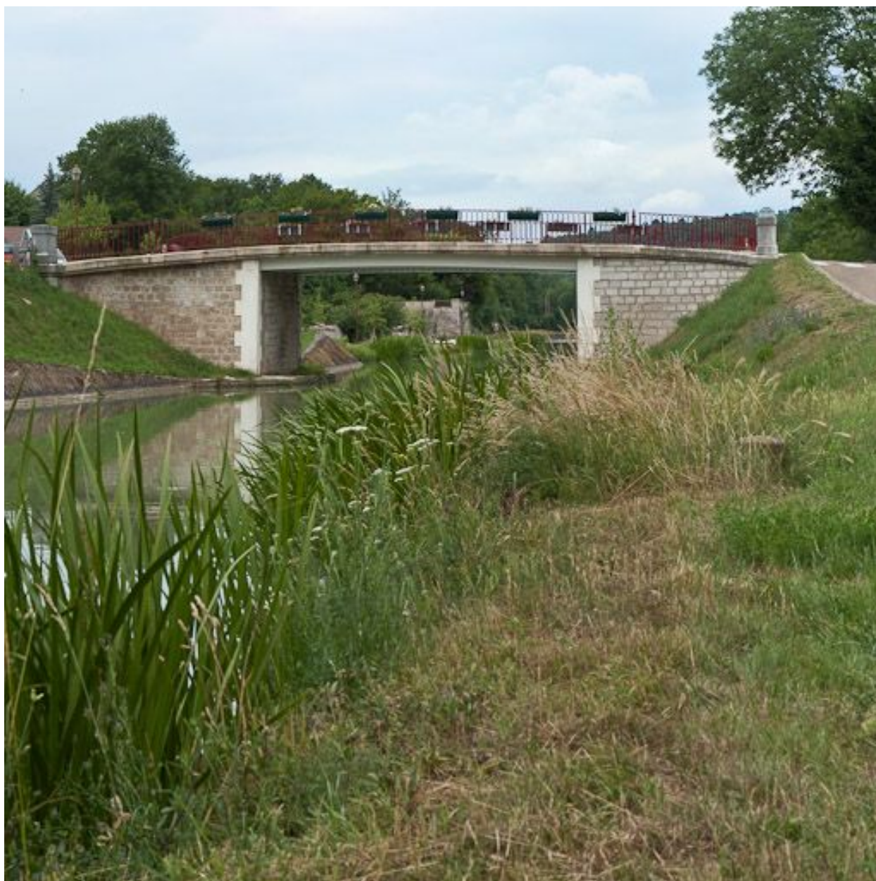
Vue du pont depuis l'aval.
