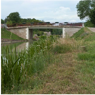
Vue du pont depuis l'aval. Phot. Pierre-Marie Barbe-Richaud IVR26_20112103552NUC2AQ
