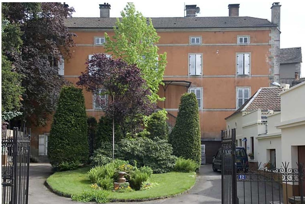
Vue d'ensemble depuis la rue.
