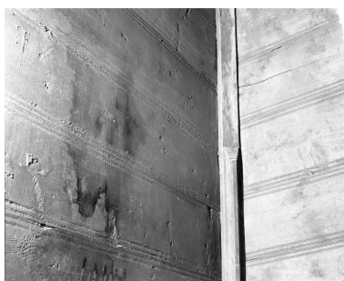
Intérieur du conduit de la cheminée en bois, détail du départ des montants verticaux dans lesquels viennent s'encaster les planches horizontales.
