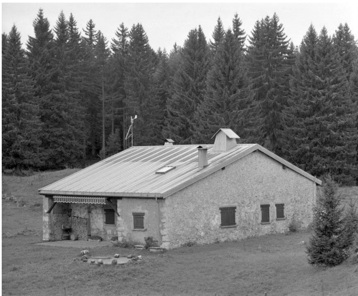
Façade antérieure et face droite.
