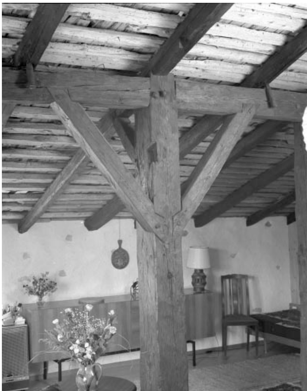
Détail de la charpente : assemblage d'un poteau avec la panne. Il manque une contre fiche dans le plan parallèle à la pente du toit.
