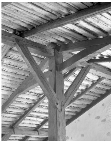
Détail de la charpente : assemblage du poteau avec la faitière.
