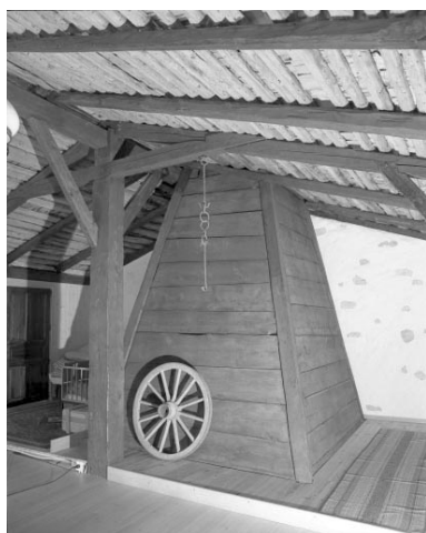
La cheminée en bois dans sa partie située dans la grange haute. Phot. Yves Sancey IVR43_19943901052X
