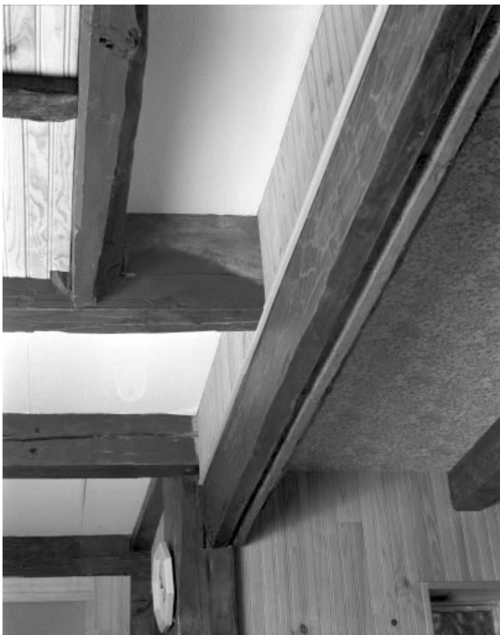
Détail de la rainure de la poutre dans laquelle venait se loger les planches de la cloison en bois, entre la cuisine et la grange.
