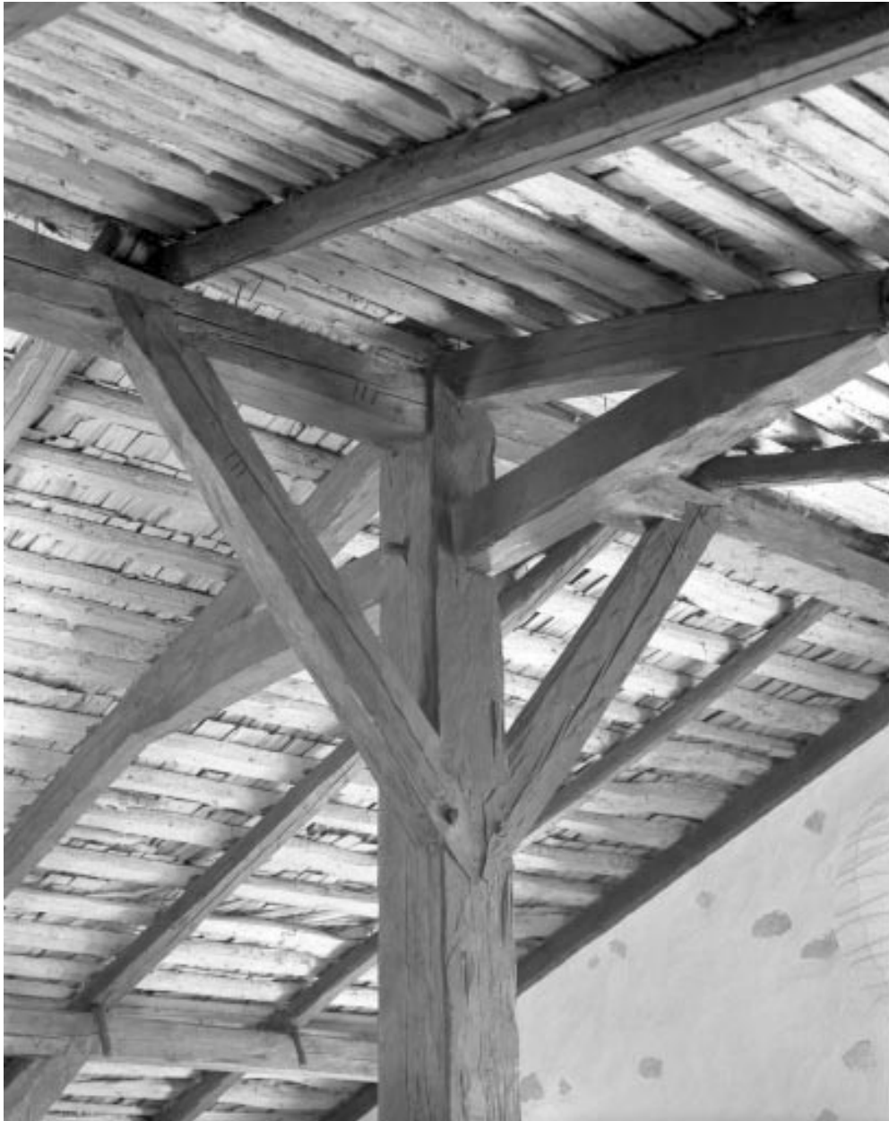
Détail de la charpente : assemblage du poteau avec la faiçière.
