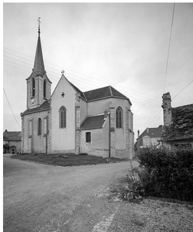
Extérieur : façade latérale droite. Phot. Yves Sancey IVR43_19757000269V
