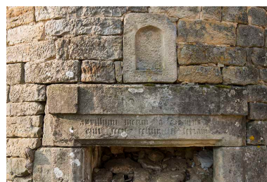
Niche située au bas de la tour. Phot. Jérôme Mongreville IVR43_20177000264NUC4A
