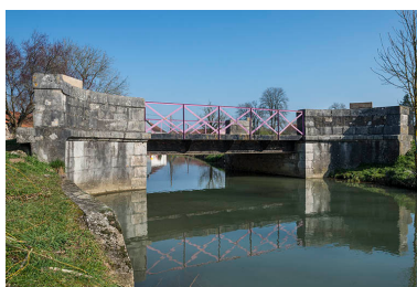
Le pont. Phot. Jérôme Mongreville IVR43_20177000273NUC4A
