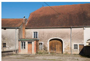
Ferme, rue principale. Phot. Jérôme Mongreville IVR43_20177000249NUC4A
