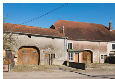
Fermes avec portes de grange. Phot. Jérôme Mongreville IVR43_20177000250NUC4A
