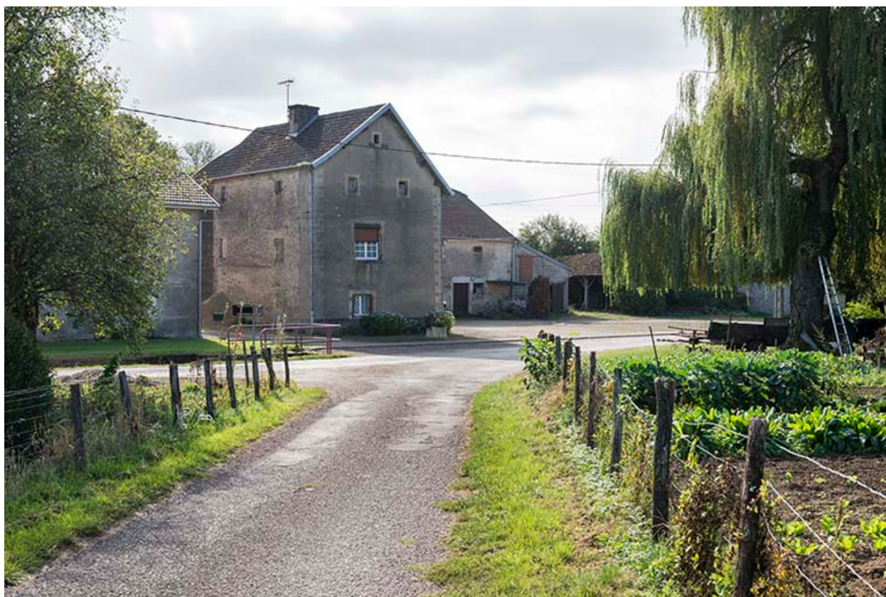
Vue depuis la rue de la Charlotte.
