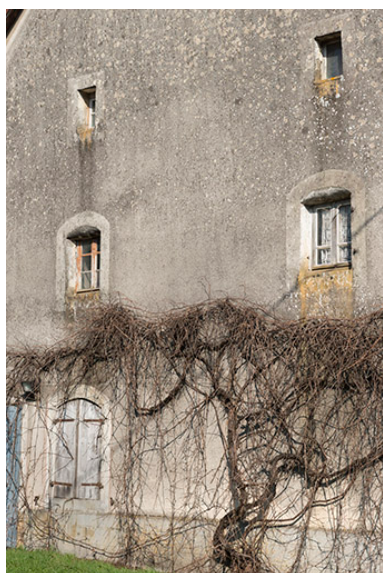
Détail des baies. Phot. Jérôme Mongreville IVR43_20177000282NUC4A
