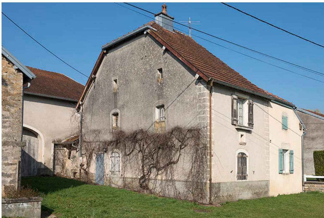
Vue sur l'usoir et la partie habitation.
