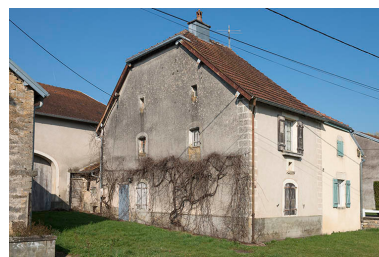
Vue sur l'usoir et la partie habitation. Phot. Jérôme Mongreville IVR43_20177000280NUC4A
