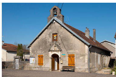
La chapelle. Phot. Jérôme Mongreville IVR43_20177000246NUC4A
