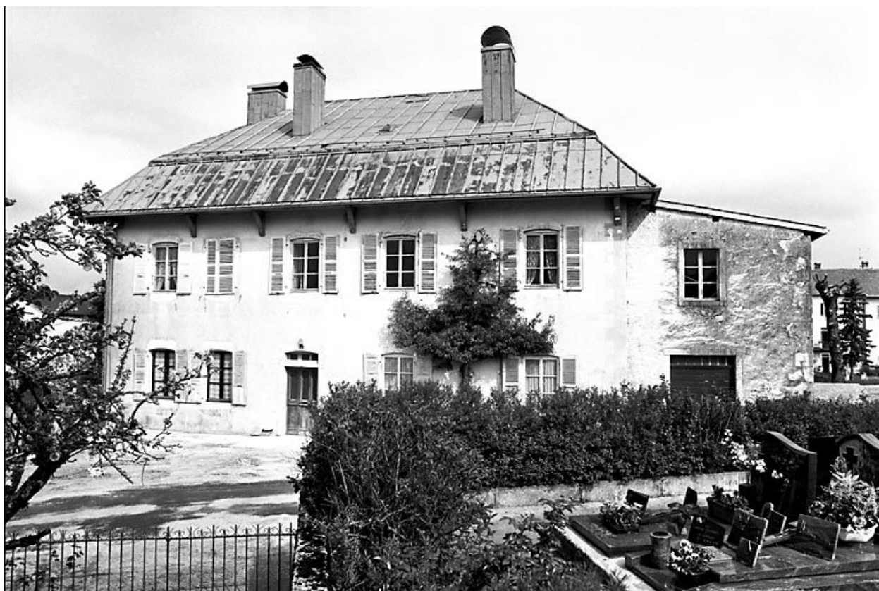
Façade antérieure vue depuis le cimetière.
