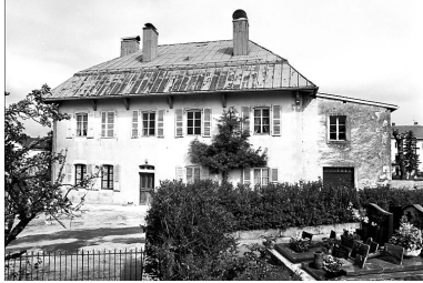
Façade antérieure vue depuis le cimetière. Phot. Jérôme Mongreville IVR43_20013900518X
