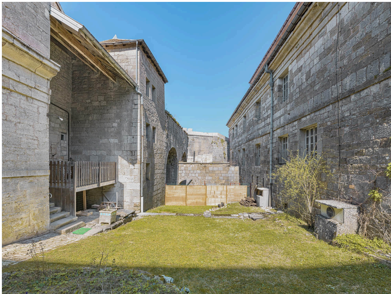
Façade postérieure (à droite).
