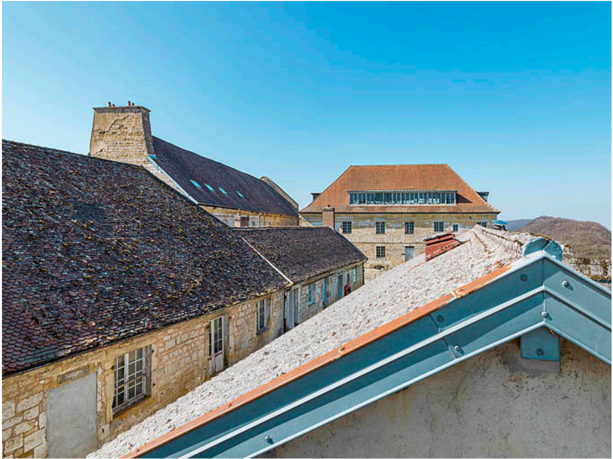
Toit à croupe du bâtiment.
