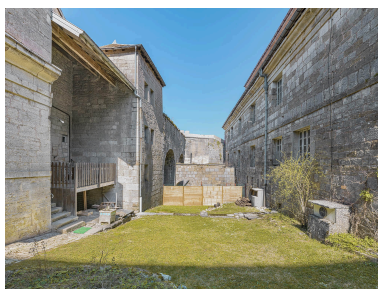
Façade postérieure (à droite). Phot. Thierry Kuntz IVR43_20223900634NUC4A
