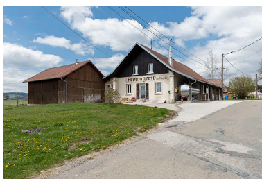
Vue d'ensemble, depuis le sud-est (avec la pièce d'affinage récente à gauche). Phot. Sonia Dourlot IVR43_20192500329NUC4A
