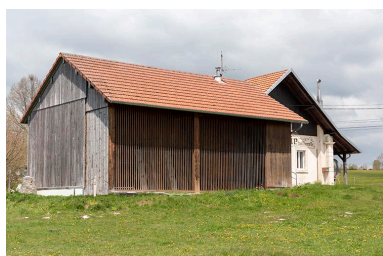
Pièce d'affinage récente, depuis le sud-ouest. Phot. Sonia Dourlot IVR43_20192500332NUC4A
