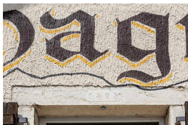
Façade antérieure : linteau daté 1895. Phot. Sonia Dourlot IVR43_20192500331NUC4A
