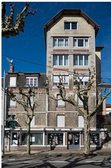
Vue de face. Phot. Jérôme Mongreville IVR43_20182500506NUC4A
