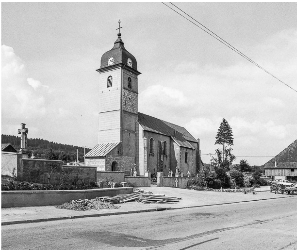
Extérieur : faces sud et ouest.
