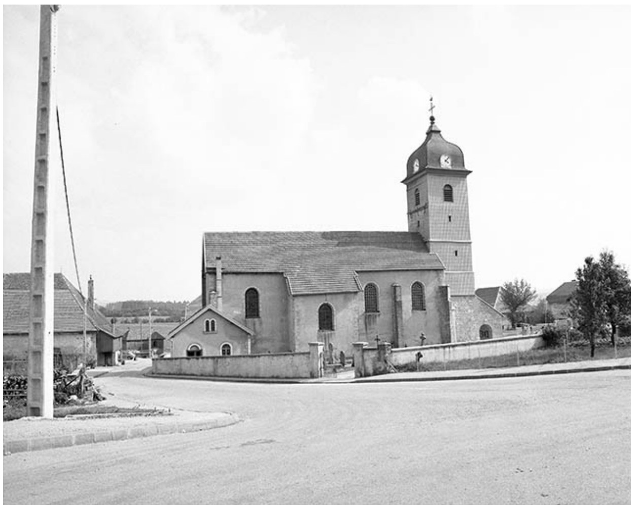
Extérieur : face latérale nord.
