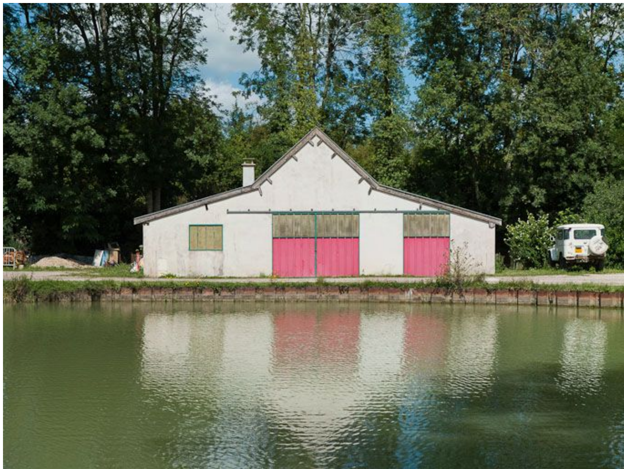
Vue d'un hangar sur le port.
