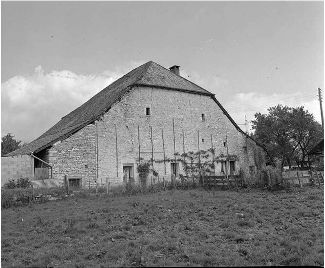
Ferme située rue de la Fontaine.
