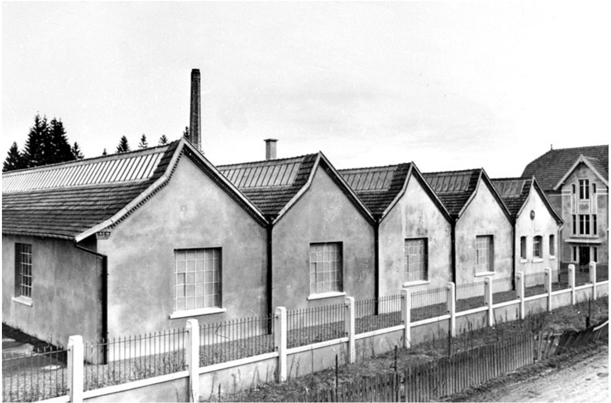
Vue des pignons sur rue vers 1945.
