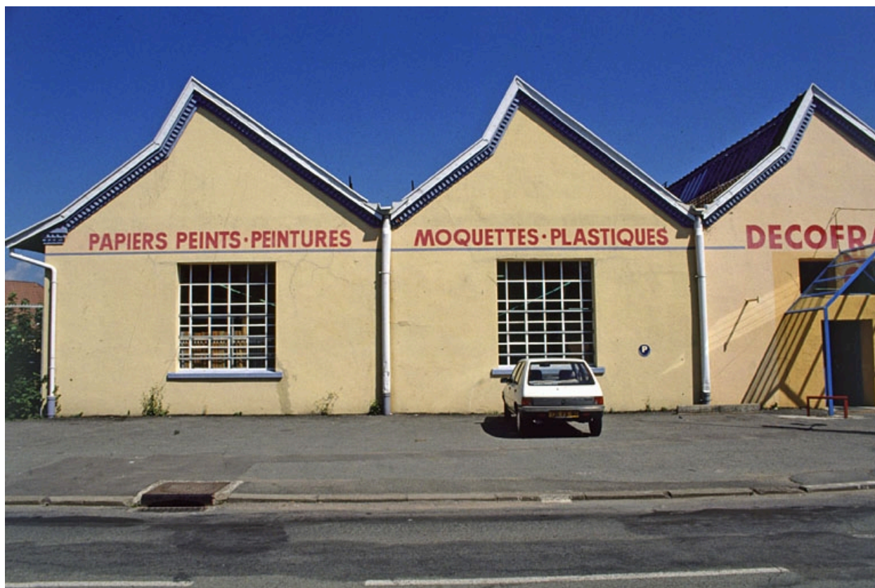
Pignons ouest de l'atelier de fabrication.
