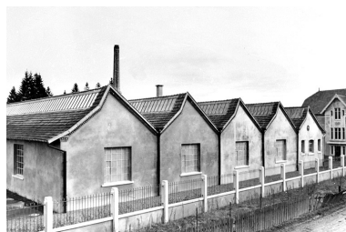
Vue des pignons sur rue vers 1945. Phot. IVR43_20009000922X
