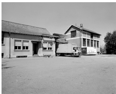
Façade sud et chaufferie. Phot. Yves Sancey IVR43_20009000214X
