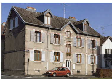
Logement ouvrier collectif à cinq travées (rue de Bussang à Belfort). Phot. Yves Sancey IVR43_20019000737ZA
