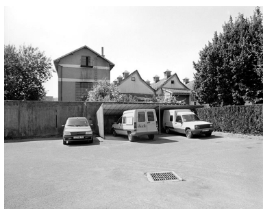
Pignons ouest de la chaufferie et de l'atelier de fabrication. Phot. Yves Sancey IVR43_20009000218X
