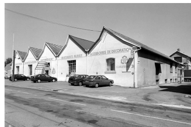
Atelier de fabrication vu depuis le sud. Phot. Yves Sancey IVR43_20009000211X
