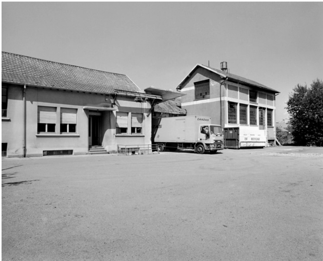
Façade sud et chaufferie.
