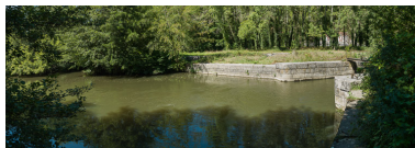
Vue du barrage.
