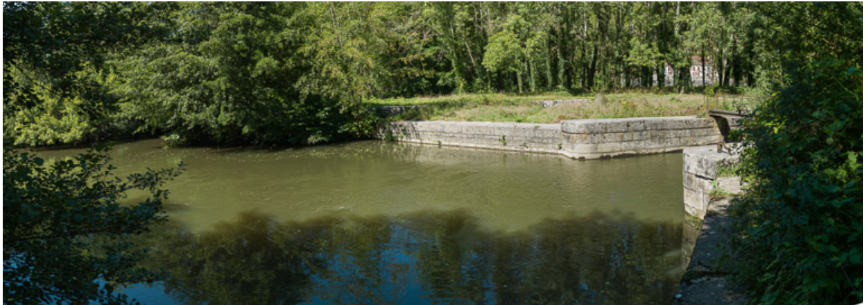
Vue du barrage.
