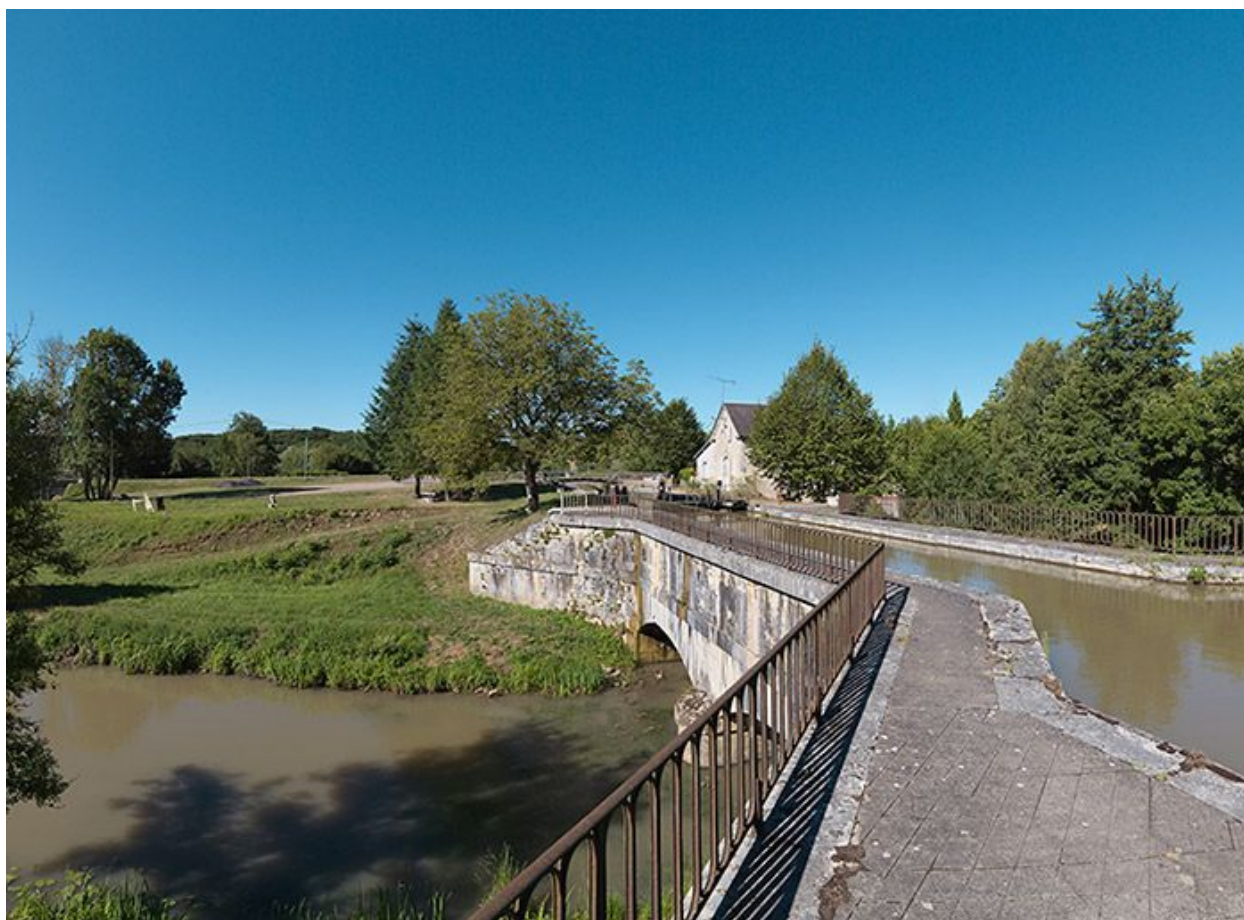
Vue d'ensemble du pont canal.
