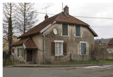
Maison ouvrière à deux logements. Phot. Jérôme Mongreville IVR43_20067000108NUCA
