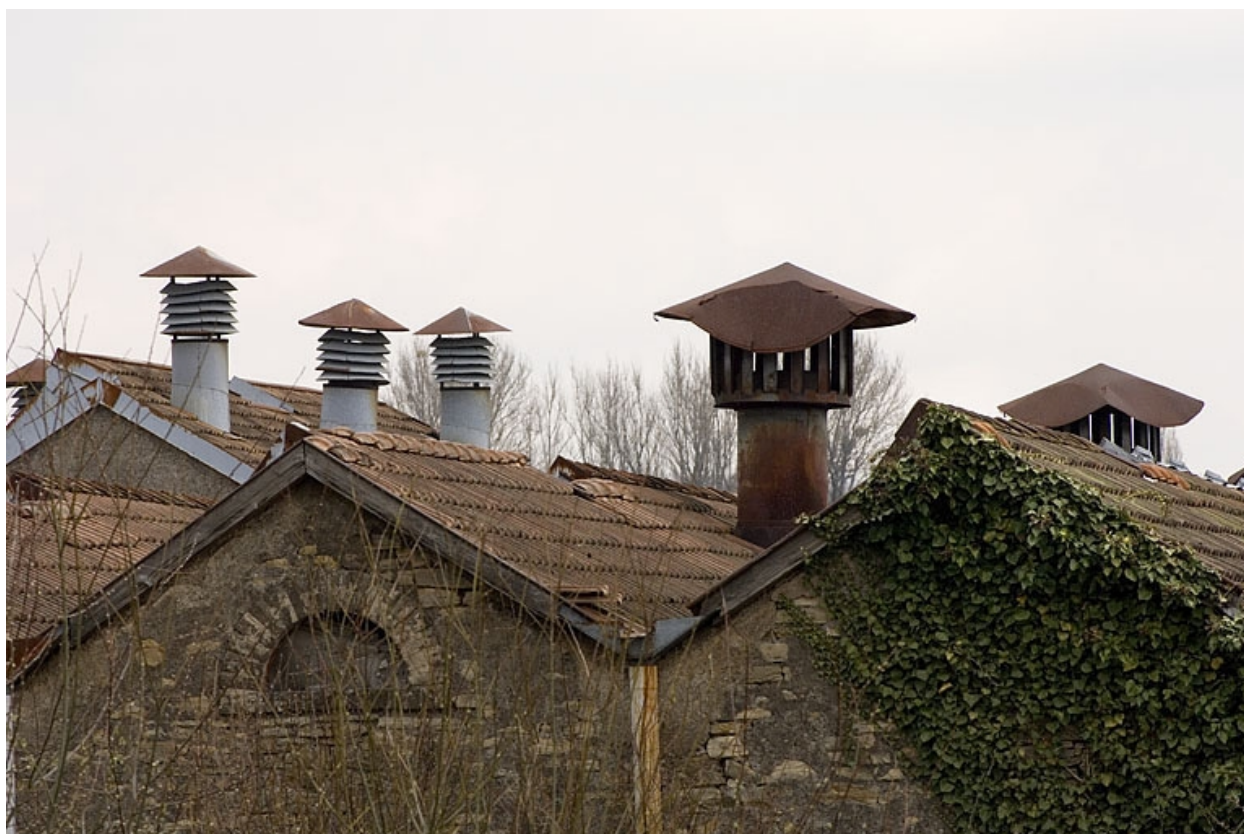
Cheminées métalliques de la salle de tissage.
