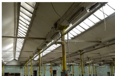
Salle de tissage. Détail des sheds. Phot. Jérôme Mongreville IVR43_20057000477NUCA
