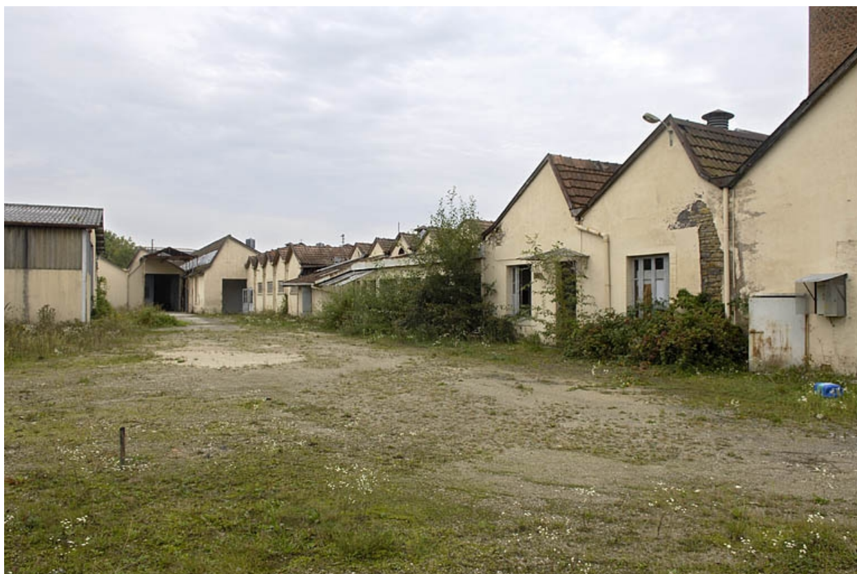
Murs-pignons nord de la salle de tissage.
