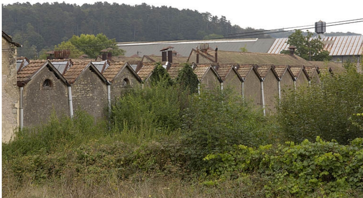
Murs-pignons sud de la salle de tissage.
