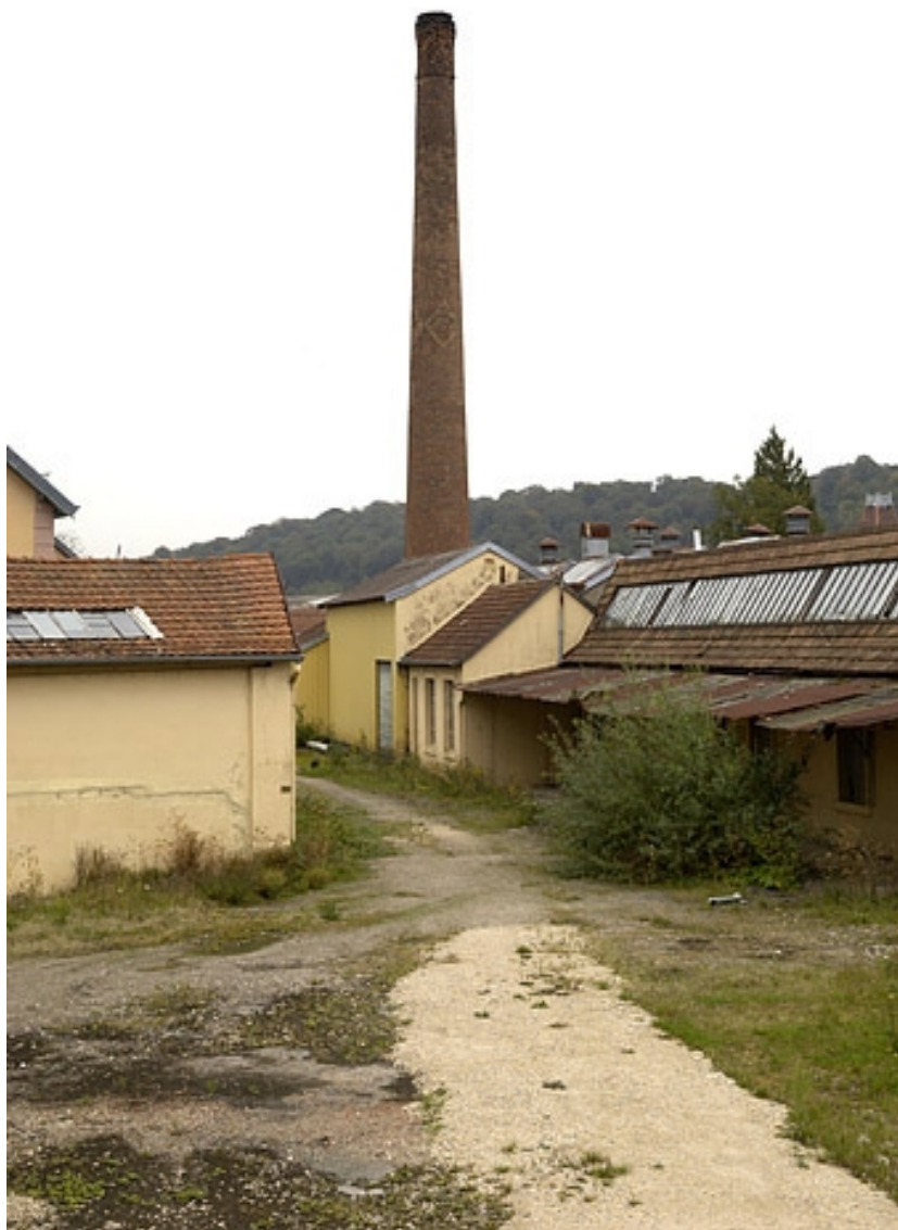
Atelier et cheminée depuis l'entrée.
