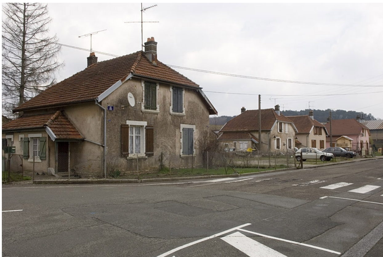
Logements ouvriers doubles rue Paul Vinot.
