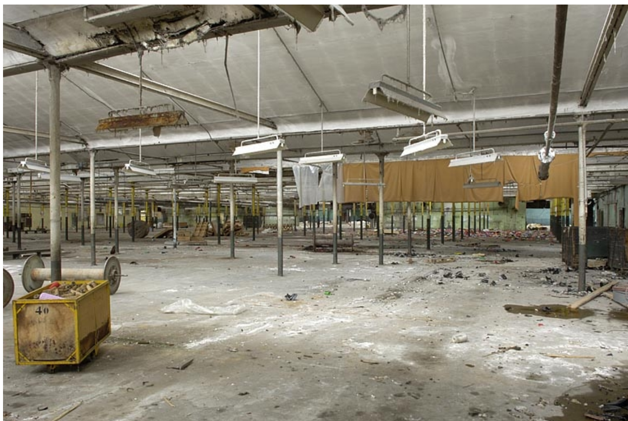
Salle de tissage. Vue d'ensemble depuis l'entrée.
