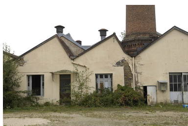
Bureau et chaufferie. Phot. Jérôme Mongreville IVR43_20057000468NUCA
