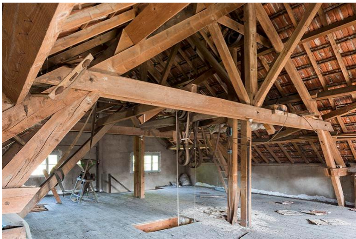
Vue d'ensemble de l'étage en surcroît
