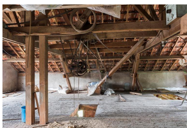
Vue de l'étage en surcroît, système de transmission par poulies et courroies et conduits fermés en bois Phot. Sonia Dourlot IVR43_20167001315NUC4A
