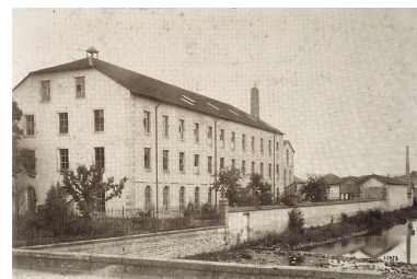
L'atelier à étages de la filature. Phot. Jérôme Mongreville IVR43_20077000007NUCA
